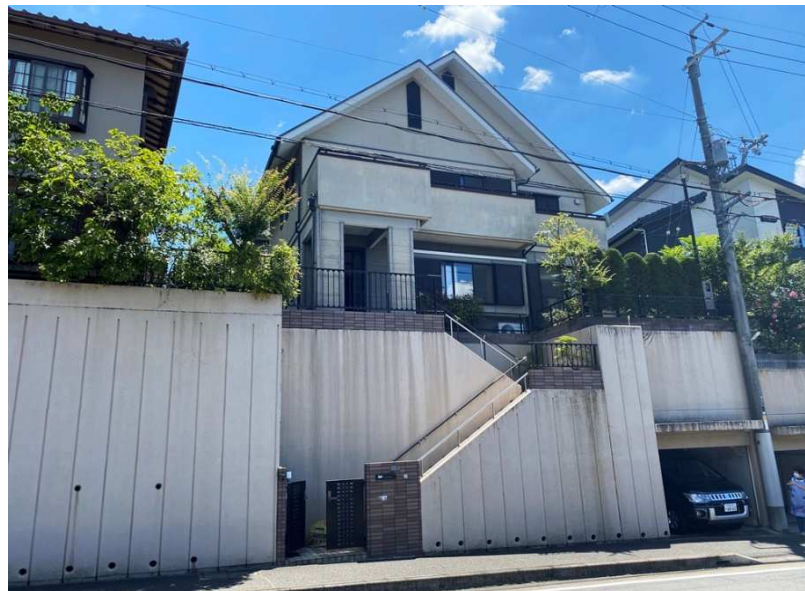
前面道路より駐車場に入り、住宅へは階段を上がります
