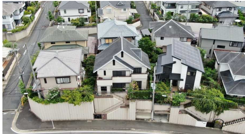
対象物件前面道路上空より見る
